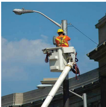
Зураг 19. Нийтийн эзэмшлийн гэрэлтүүлгийн шонд цэвэрлэгээ үйлчилгээ хийж буй байдал (Жишээ зураг)
