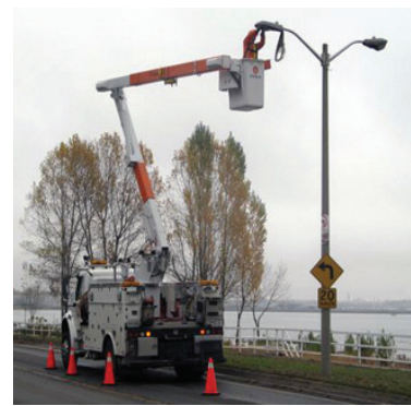
Зураг 19. Нийтийн эзэмшлийн гэрэлтүүлгийн шонд цэвэрлэгээ үйлчилгээ хийж буй байдал (Жишээ зураг)
