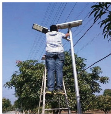
Зураг 19. Нийтийн эзэмшлийн гэрэлтүүлгийн шонд цэвэрлэгээ үйлчилгээ хийж буй байдал (Жишээ зураг)
